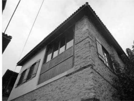
Fotoğraflar (Restorasyon öncesi ve sonrası durum)
